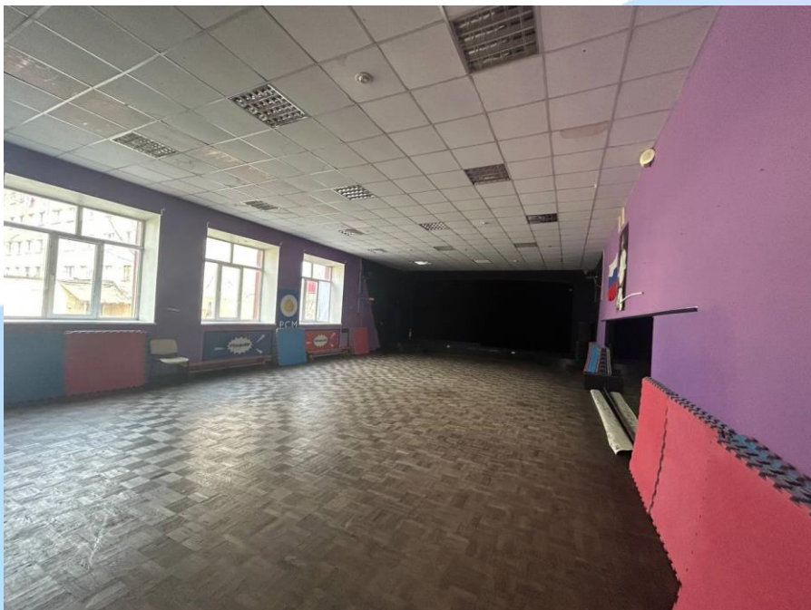
ТЕКУЩЕЕ СОСТОЯНИЕ АКТОВОГО ЗАЛА
